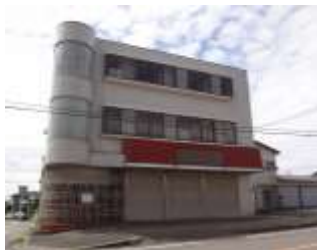
多世代交流拠点南粕谷ハウス★ (1階部のみ)
